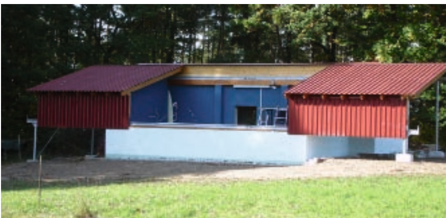
Die zur Seite gefahrenen Hälften des Abrolldachs geben die geräumige Beobachtungsplattform der Sternwarte frei.
