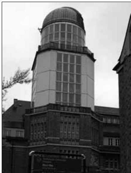
Beyer-Bau der TU Dresden mit Sternwarkuppel
